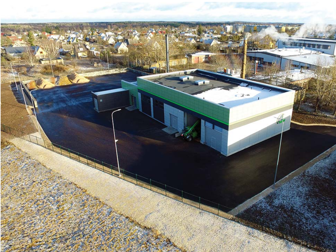
Tapa reservkatlamaja. Foto: N.R. Energy OÜ
