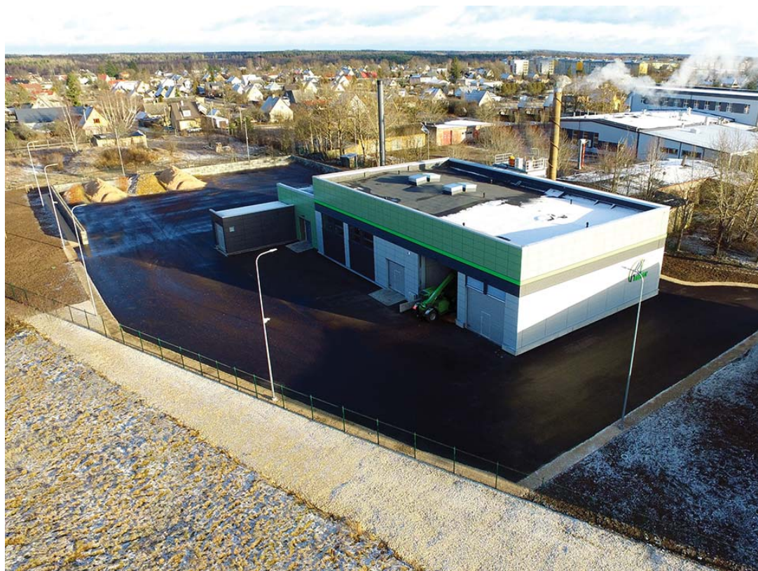
Tapa reservkatlamaja. Foto: N.R. Energy OÜ
