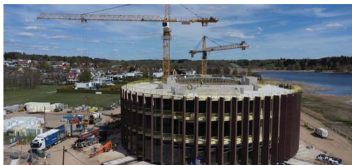
Ehitusega on jõutud sellisesse etappi, kus möödujate jaoks tundub, et kompleks saab kohe-kohe valmis. Suuremahulised konstruktiivsed ehitustööd on tõesti nüüdseks selja taga, aga ehituslikus mõttes ollakse siiski alles poole peal – edasine töö toimub valdavalt siseruumides.
