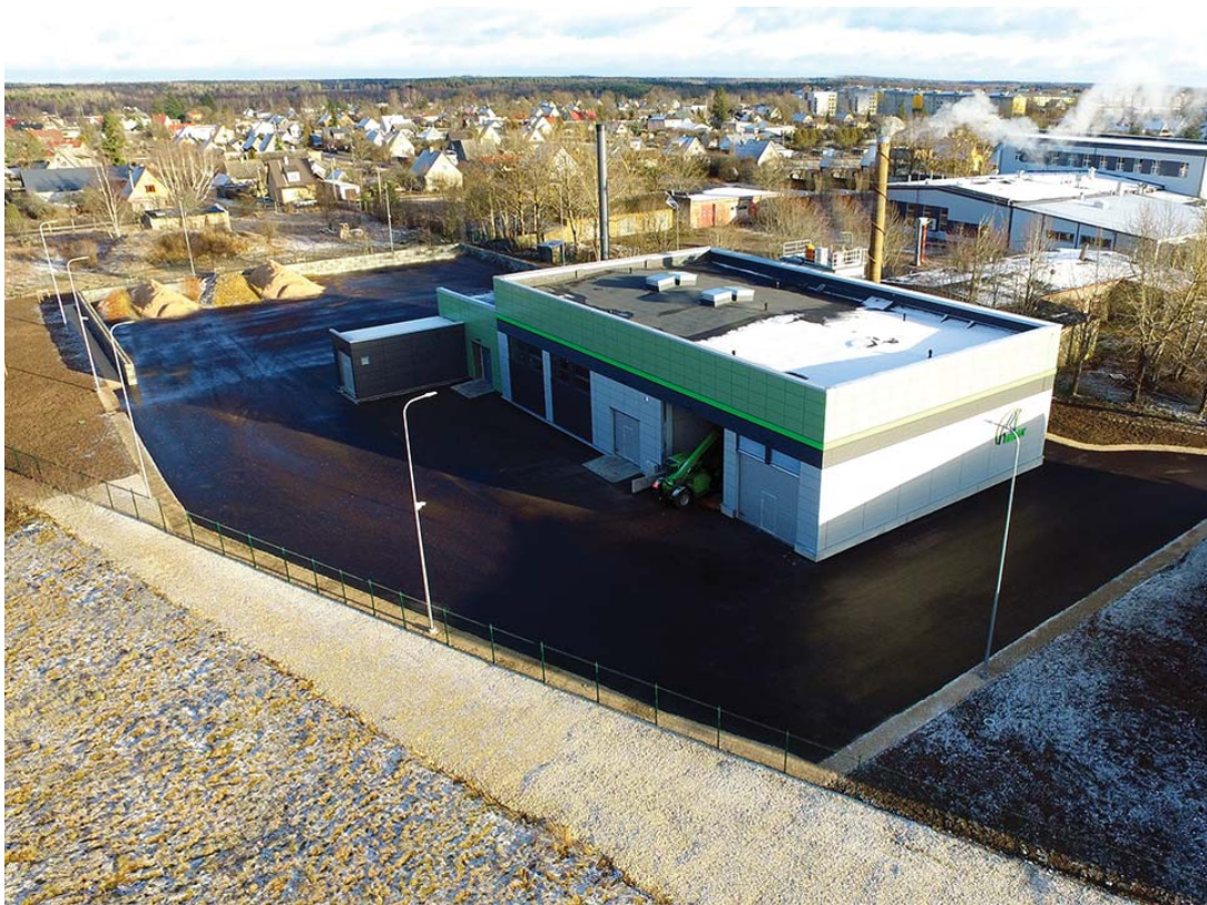
Tapa reservkatlamaja. Foto: N.R. Energy OÜ
