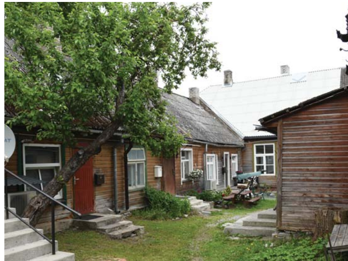
Hubane sisehoov Rakvere muinsuskaitsealal, näha on 18. sajandi teisest poolsest pärit tänavaäärsele hoonele 19. sajandil tehtud juurdeehitused.
