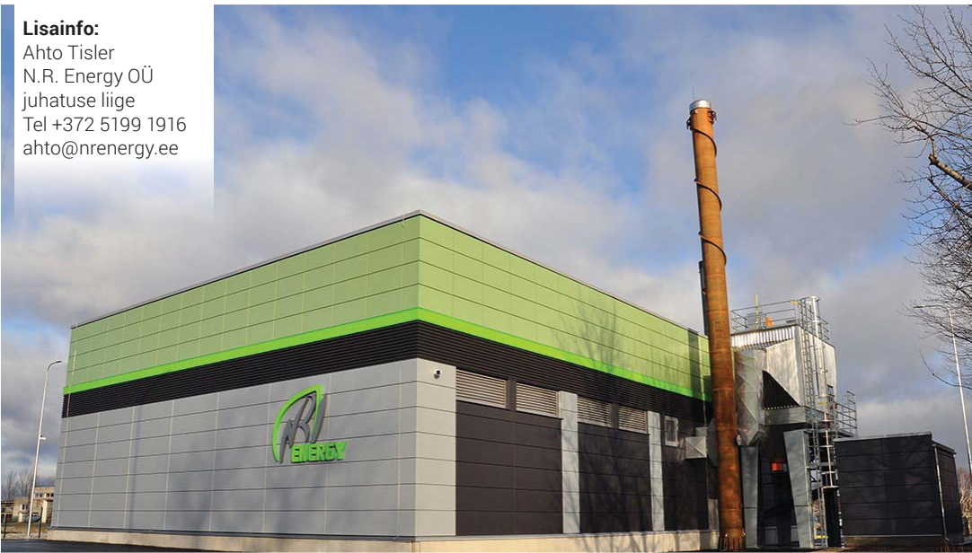
Leina tänaval paiknev Tapa moodne reservkatlamaja võeti kasutusse eelmisel küttehoojal. Foto: N.R. Energy
