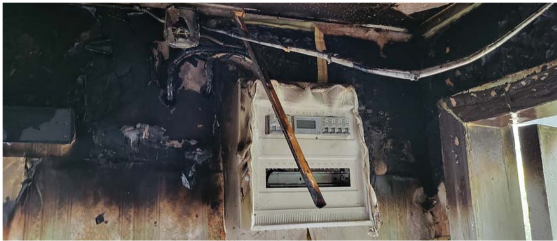
Elektrijuhtmestikust alguse saanud maja põlengu tagajärjel hävinesid osaliselt koridori seinad, ülejäänud maja jäi terveks. Foto: Päästeamet
