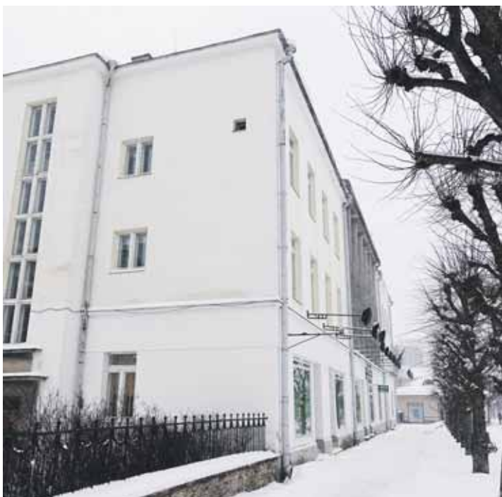
Kõige vajalikumad tööd Rakvere ajaloolises pangahoones on seotud kanalisatsiooni, ventilatsiooni ja küttesüsteemidega.
