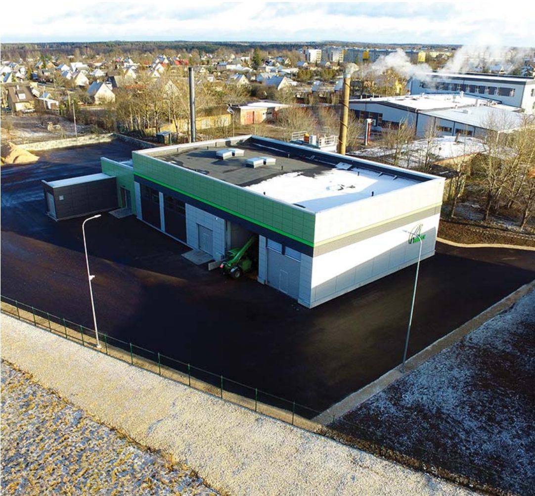
Uus Leina tänava reservkatlamaja lubab tavaolukorras kütta kogu Tapa linna taastuenergiaga. Foto: N.R. Energy
