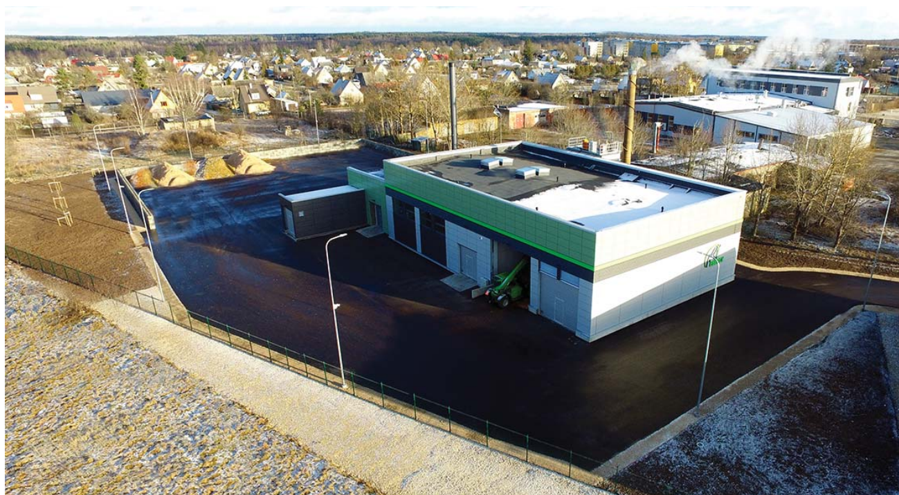
Tapa reservkatlamaja. Foto: N.R. Energy OÜ
