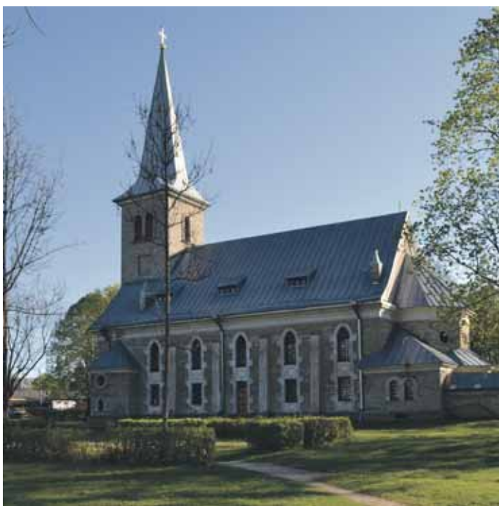
Projektirahastuse toel loodetakse uuendada Tapa Kiriku- ja Kultuurikoja park.
