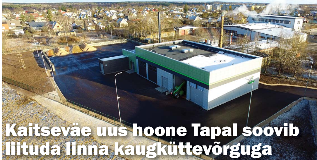
Tänavu veebruari alguses kasutusse võetud Tapa uue reservkatlamaja. Foto: N.R. Energy
