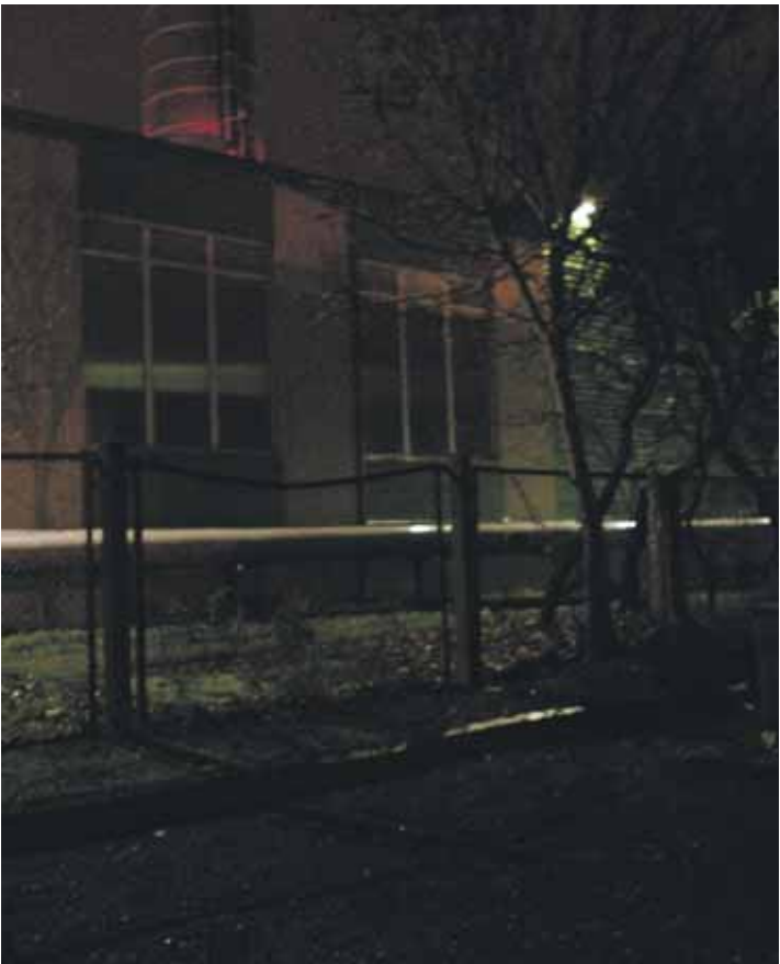
Rakvere Soojuse Lembitu tänava katlamaja.
